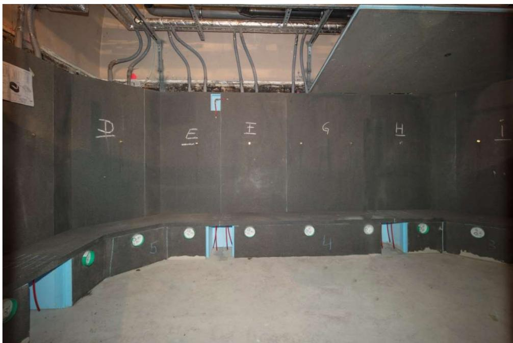
Las paredes del baño de laconio y vapor del baño Neptunbad están formadas por elementos prefabricados que el procesador sólo tenía que montar y pegar. Los asientos de banco también fueron prefabricados en la fábrica. Una configuración de prueba en el wedi en la sala de la fábrica aseguró que todos los elementos encajaban perfectamente en el sitio de construcción.
