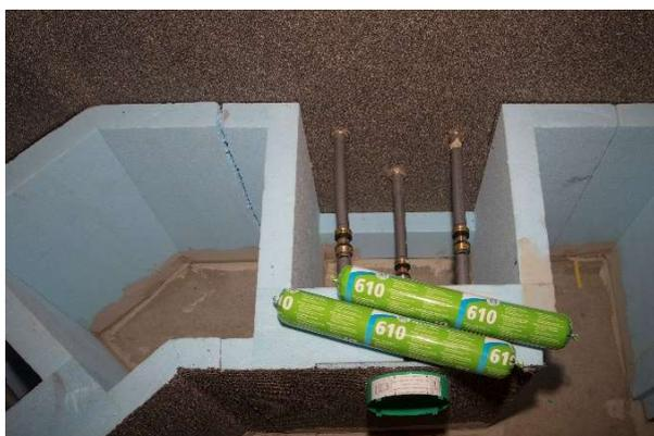
Las cajas I-Box y los tubos de conexión para los soportes de la banqueta ya se instalaron y sellaron en fábrica. Antes de que la superficie del asiento pudiera pegarse a los elementos de soporte con wedi 610, el instalador conectó los tubos.
