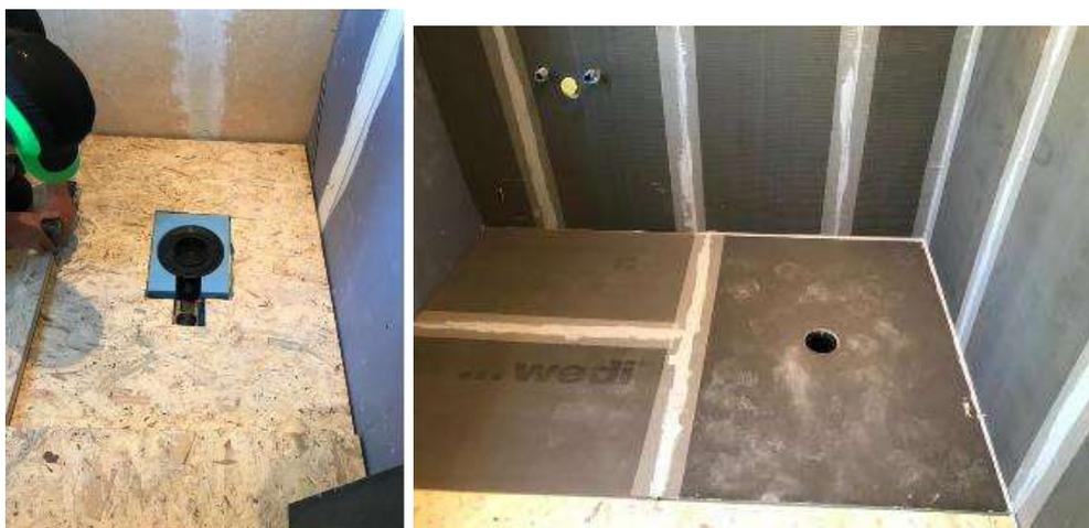
Se utilizó una base de drenaje wedi para las duchas con el mismo nivel del suelo. Los artesanos le pusieron el elemento de ducha Fondo Primo. El suelo alrededor de la ducha está cubierto con placas de construcción wedi para proteger el delicado suelo de madera de la humedad.
